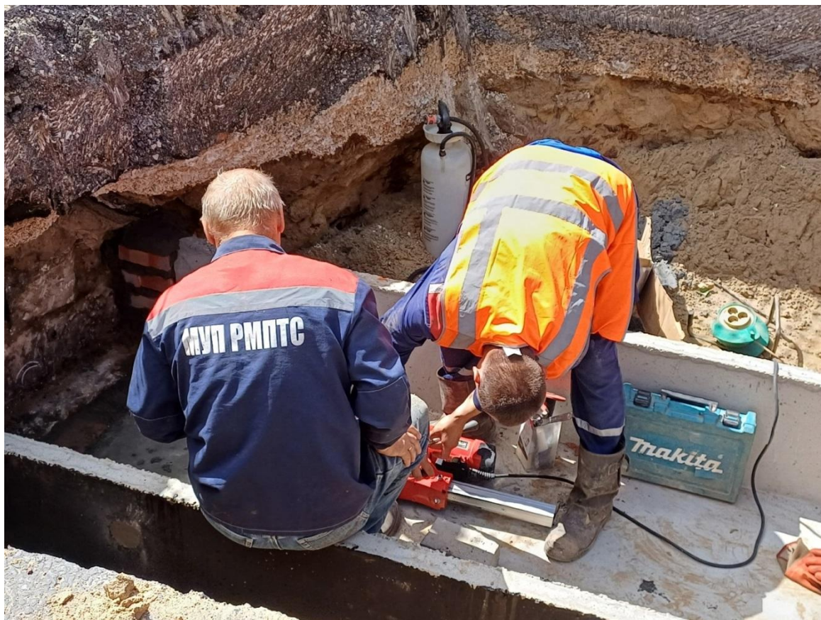
Работы по замене тепловой сети в г. Рязани.
