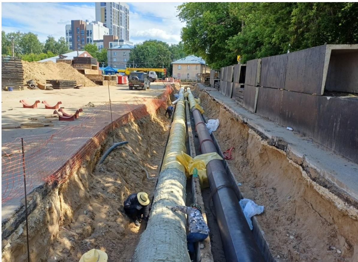
Монтаж основного трубопровода тепловой сети обеспечивающий теплом жителей центра города Рязани.
