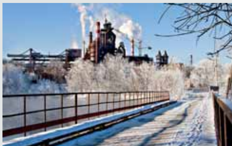
▲ ОАО «Косогорский металлургический завод»
