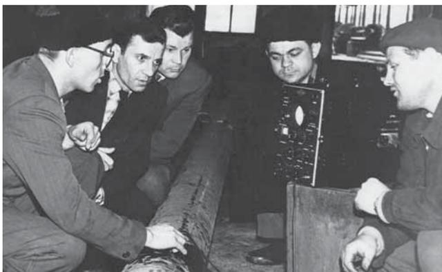
▲ Первая в нефтяной промышленности СССР ультразвуковая диагностика трубы после сварки
